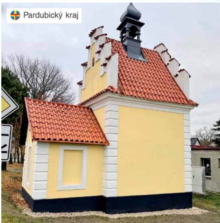
Rekonstrukce kapličky v Popkovicích
