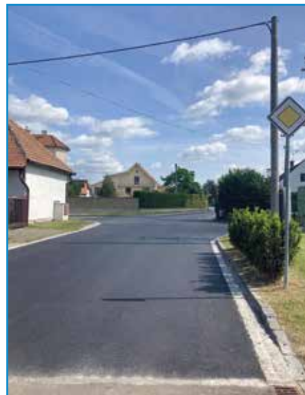
V Mněticích byla opravena komunikace ulice Ke Hrázi.
