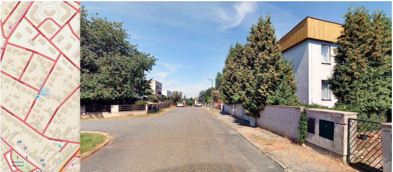
Příklad existujícího oplocení (ulice Komenského)
