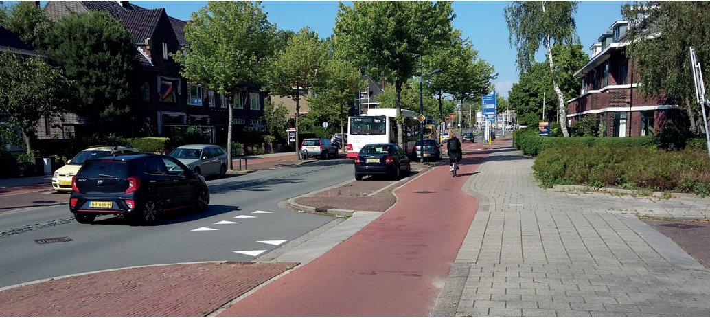
Možné uspořádání uličního profilu páteční komunikace. Napojení vedlejší komunikace (vpravo) na hlavní (vlevo) přes chodník a jednosměrnou cyklistickou stezku. Toto řešení vytváří bezpečné křížení cyklostezky s vedlejší komunikací, kdy cyklisté mají přednost v jízdě. Automobily přijíždějící zprava z vedlejší ulice, nebo odbočující z hlavní, přejíždí zvýšený chodník a cyklostezku. Jedná se o samovysvětlující řešení, kdy nejen značky, ale i samotné stavební řešení sděluje řidiči, kdo má přednost v jízdě. Delft, Nizozemsko, Foto: Z. Sperat
