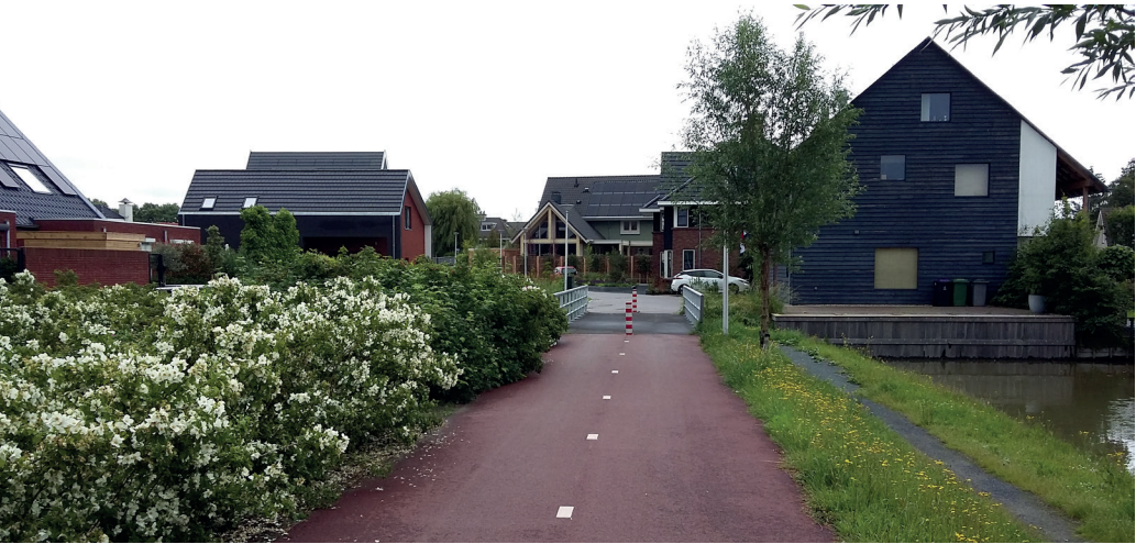
Cyklopěší stezka propojující obytné celky (obytné zóny) nebo obslužné komunikace u rodinných domů. Automobily nemohou projet a zkrátit si cestu, protože vjezd na lávku je přehrazen sloupky. Delft, Nizozemsko, Foto: Z. Sperat
