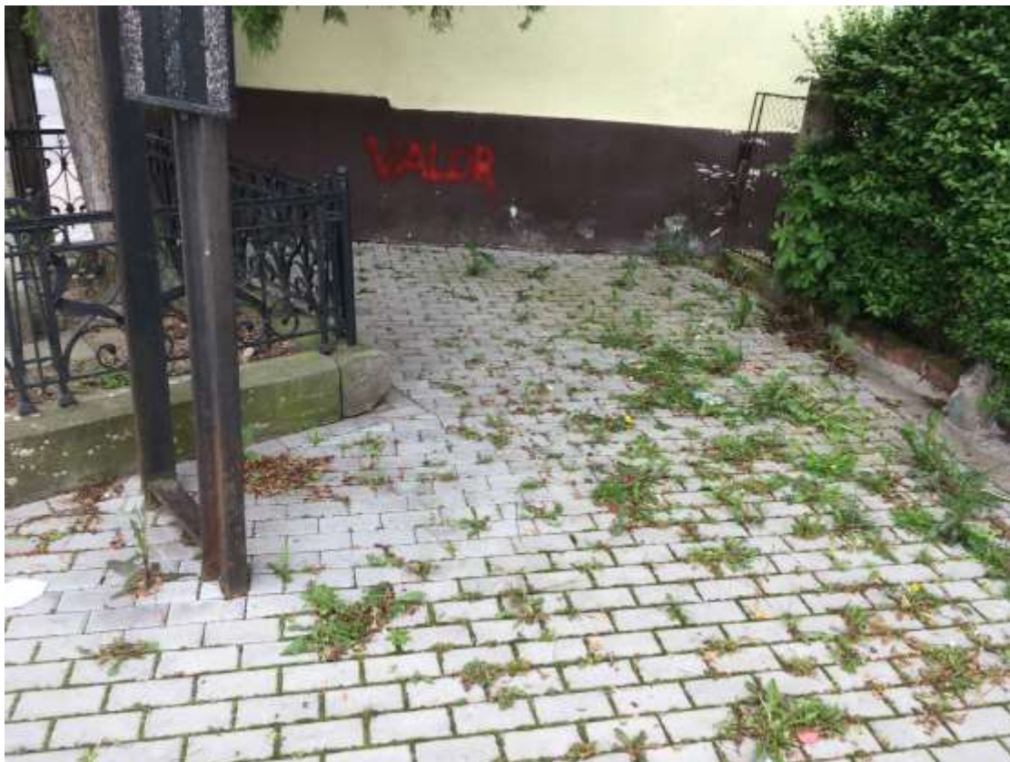
Fotky k bodu 1) d – masivní prorůstání tráv a plevelů na novém chodníku v ul. Na Zábouří
