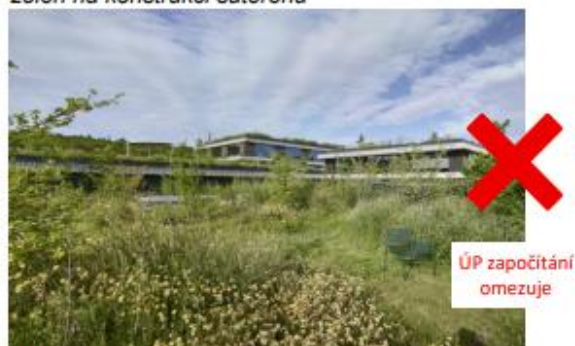
zeleně na střešní konstrukci
