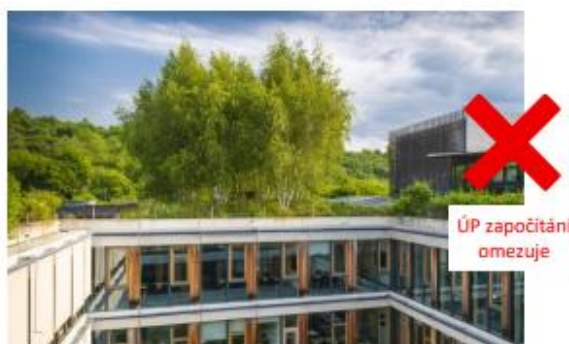
zeleně na střešní konstrukci
