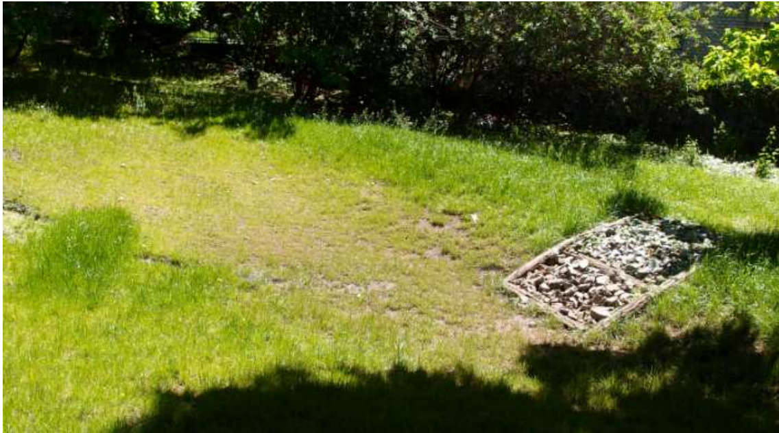
Obr. 5 - Vsakovací průleh s funkcí půdního filtru pro čištění srážkové vody (Park Klamovka, Praha).
