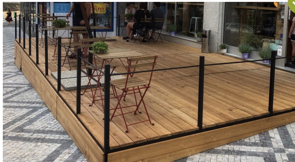
Kvalitně provedená podesta s jednoduchým subtilním zábradlím.
