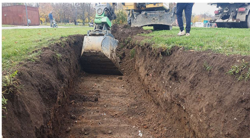
Celková výměna půdy pro zajištění prokořenitelného prostoru.
