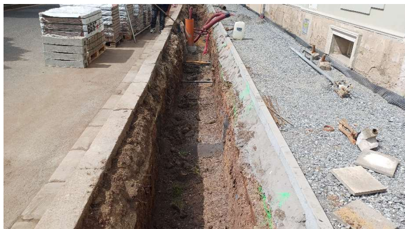
Příprava podzemní rýhy pro výsadbu v nevhodných podmínkách.
