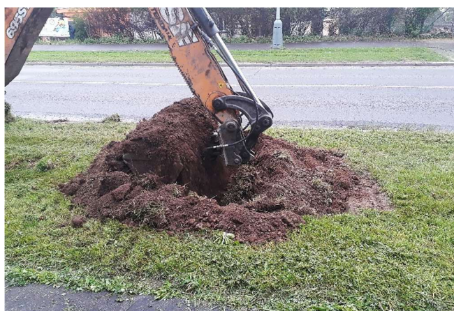
Strojní kypření a homogenizace půdy.
