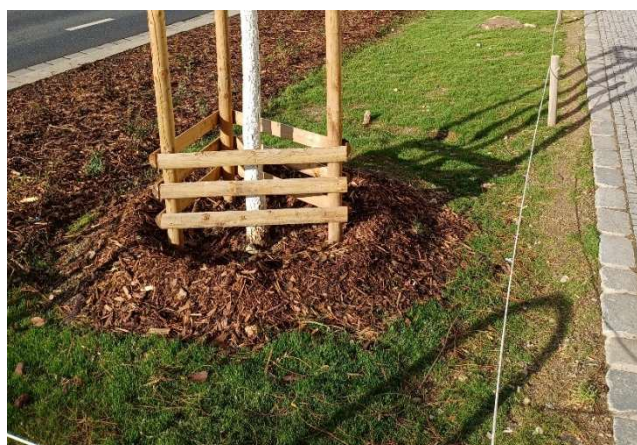
Detail provedení závlahové mísy s mulčem.
