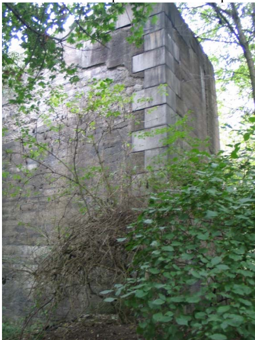
Foto 8: Pohled na původní betonové pilíře v místě plánovaného přemostění Chrudimky.
