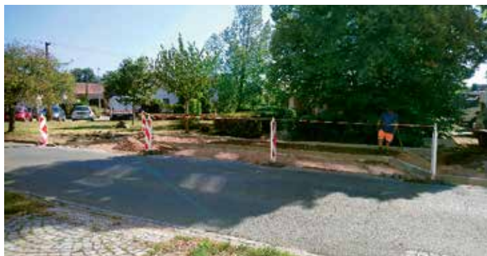
Úpravy parkovacích ploch a zálivů K + R na Školním náměstí v Rosicích n/L
