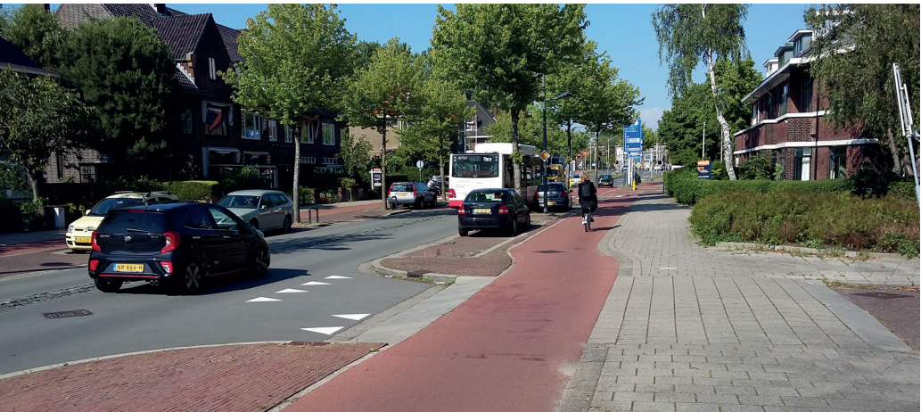
Možné uspořádání uličního profilu páteřní komunikace. Napojení vedlejší komunikace (vpravo) na hlavní (vlevo) přes chodník a jednosměrnou cyklistickou stezku. Toto řešení vytváří bezpečné křížení cyklostezky s vedlejší komunikací, kdy cyklisté mají přednost v jízdě. Automobily přijíždějící zprava z vedlejší ulice, nebo odbočující z hlavní, přejíždí zvýšený chodník a cyklostezku. Jedná se o samovysvětlující řešení, kdy nejen značky, ale i samotné stavební řešení sděluje řidiči, kdo má přednost v jízdě. Delft, Nizozemsko, Foto: Z. Sperat
