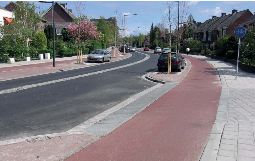
Napojení vedlejší komunikace (vpravo) na hlavní (vlevo) přes chodník a cyklistickou stezku. Toto řešení vytváří bezpečné křížení cyklostezky s vedlejší komunikací, kdy cyklisté mají přednost v jízdě. Oddělení protisměrných jízdních pruhů je provedeno ze zvýšené hrubé žulové dlažby, což zabraňuje předjíždění/přejíždění ve vysoké rychlosti. Jedná se o samovysvětlující řešení, kdy nejen značky, ale i samotné stavební řešení sděluje řidiči, kdo má přednost v jízdě. Delft, Nizozemsko, Foto: Z. Speratt
