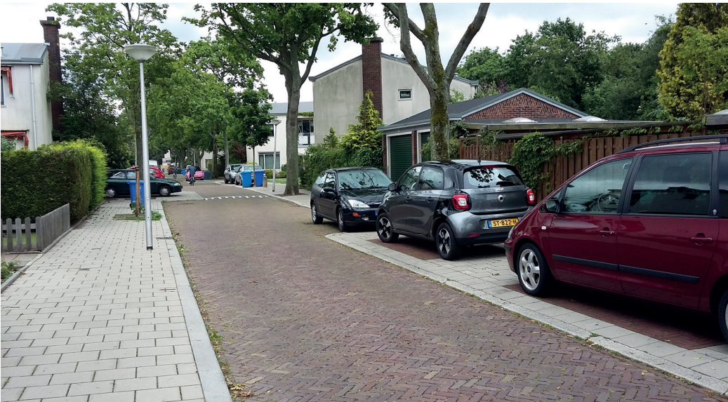
Příklad řešení uličního profilu v zástavbě rodinných domů. Komunikace má dlážděný povrch, zvýšené plochy a směrové vedení komunikace se střídavým umístěním parkování vlevo a vpravo si vynucují pomalou rychlost jízdy. Delft, Nizozemsko, Foto: Z. Sperat
