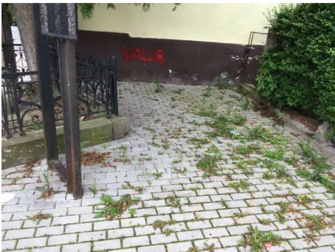
Fotky k bodu 1) d – masivní prorůstání trávy a plevelů na novém chodníku v ul. Na Záboří
