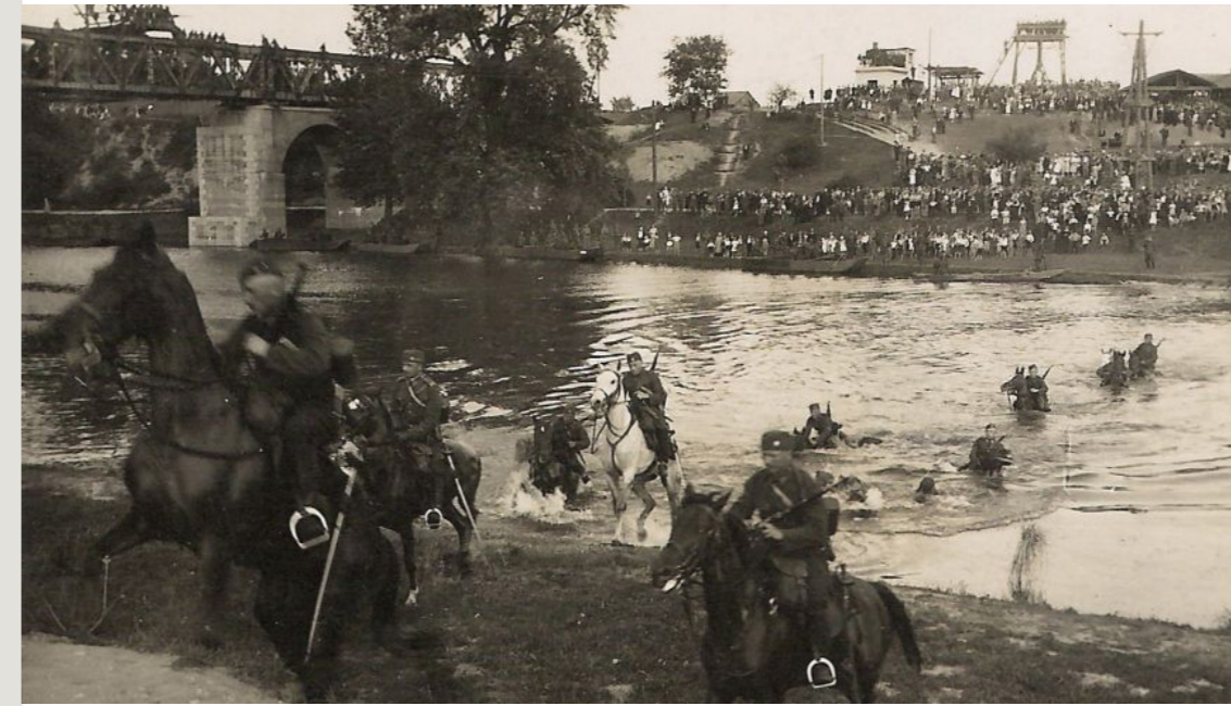
obr.50 Návčik brodění u viaduktu pod důstojnickým břehem.
