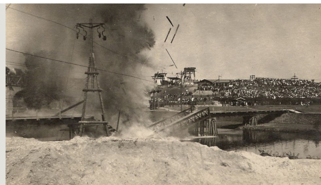
obr.43 Cvičný odstřel mostu, dnešního Zeleňáku, za mostem je vidět bývalá lanovka vedoucí od vyvýšeniny vedle důstojnického klubu, směrem k zastávce Technické cvičiště na levém břehu. Vedle lanovky je vidět budova důstojnického klubu.
