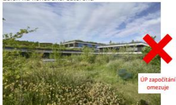
zeleň na střešní konstrukci
