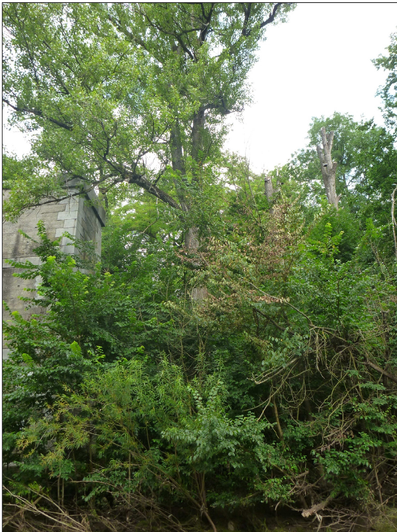
Pohled na porost u pilíře mobilního mostu. Křoviny je žádoucí odstranit, vzrostlý topol černý ponechat. Stejně tak torza topolů v pozadí. Při nutnosti zásahu (bezpečnost) torza ponechat na lokalitě.
