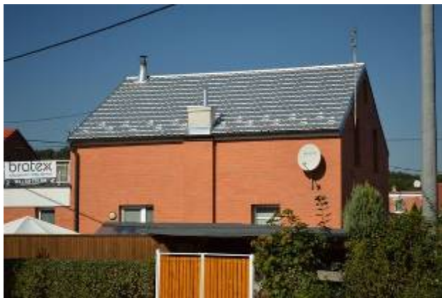
Bílá kovová střecha české produkce (zdroj: www.krytiny-strechy.cz )
