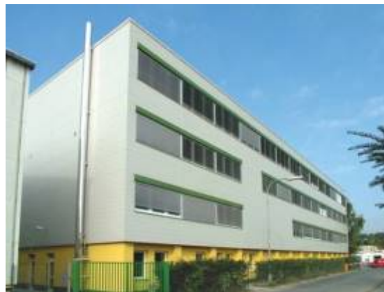
Odvětratelná fasáda ve světlém provedení (zdroj: www.konstrukce.cz )
