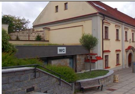
Extenzivní zelená střecha na budově veřejných toalet v Uherském Brodě (zdroj: www.ub.cz)
