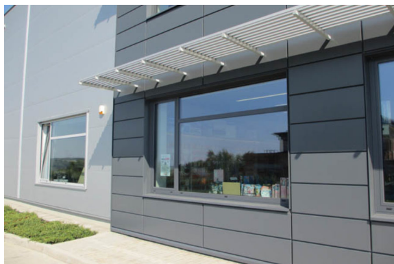
Okenní slunolam na budově firmy Astra v Uherském Brodě (zdroj: www.atenasro.cz)
