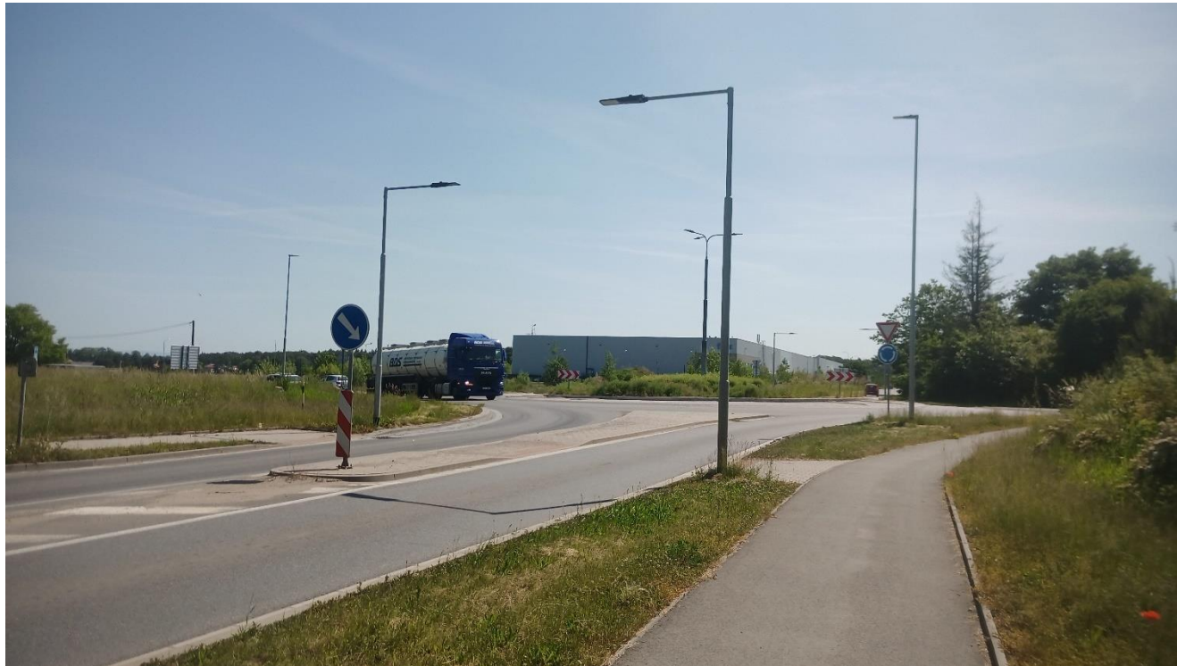
Kruhový objezd na silnici II/322, logistický areál
