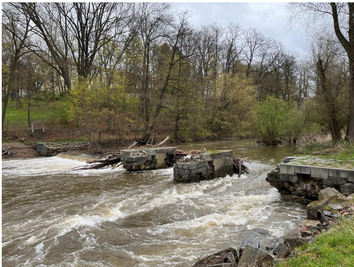
Obr. Pozůstatky historického jezu při průchodu menší jarní povodně (duben 2023)
