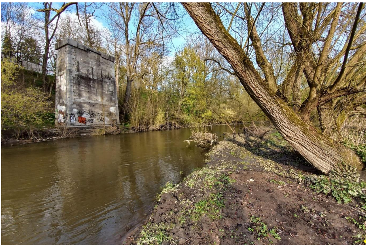
Obr. Meandr nad jezem, na pravém břehu mostní pilíř a viditelná linie opevnění kynety, na levém břehu povodňové hlíny.
