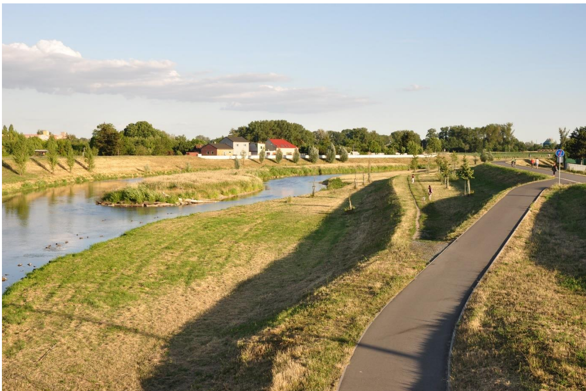
Obr. Ilustrační foto možné podoby přístupné bermy v kombinaci s protipovodňovou hrází - berma řeky Moravy v Olomouci
