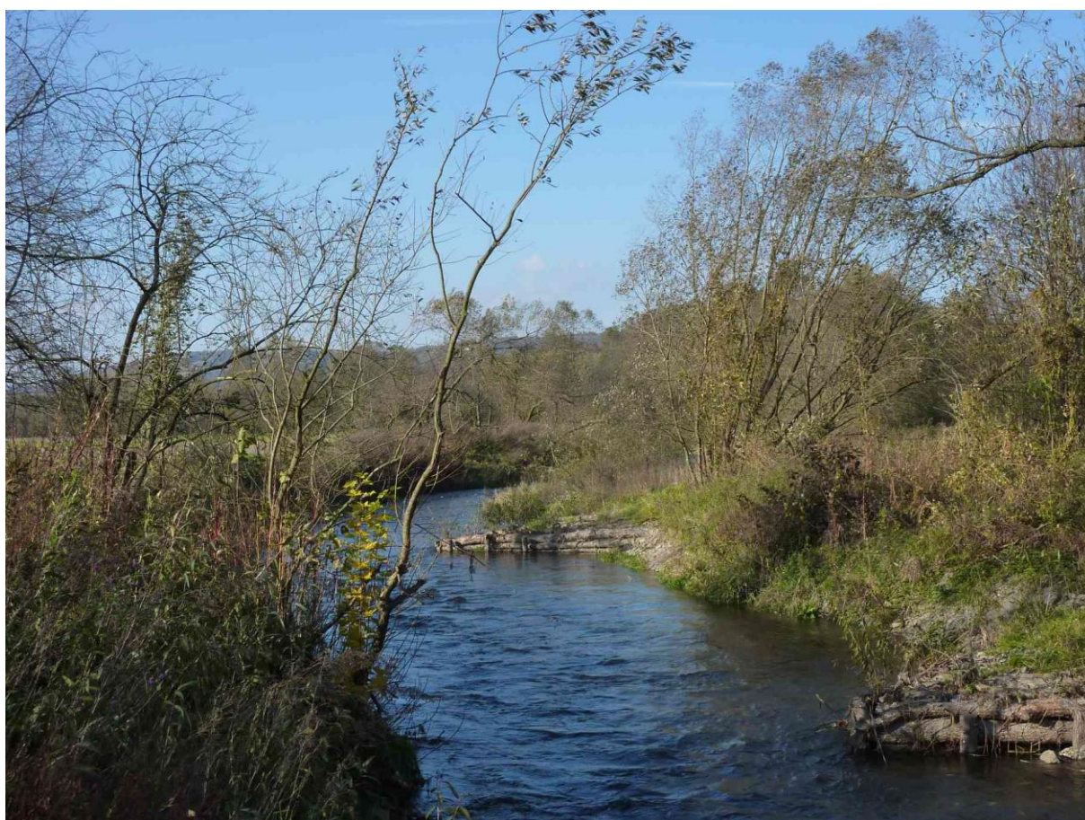
Obr. Ilustrační foto břehových usměřovačů proudu s využitím kulatiny na Odře u Mankovic
