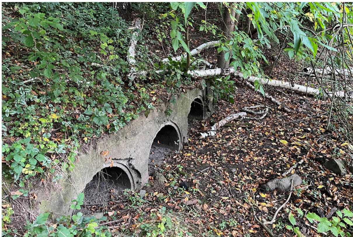
Obr. Původní nátokový objekt pro přívod vody do Zimního přístavu
