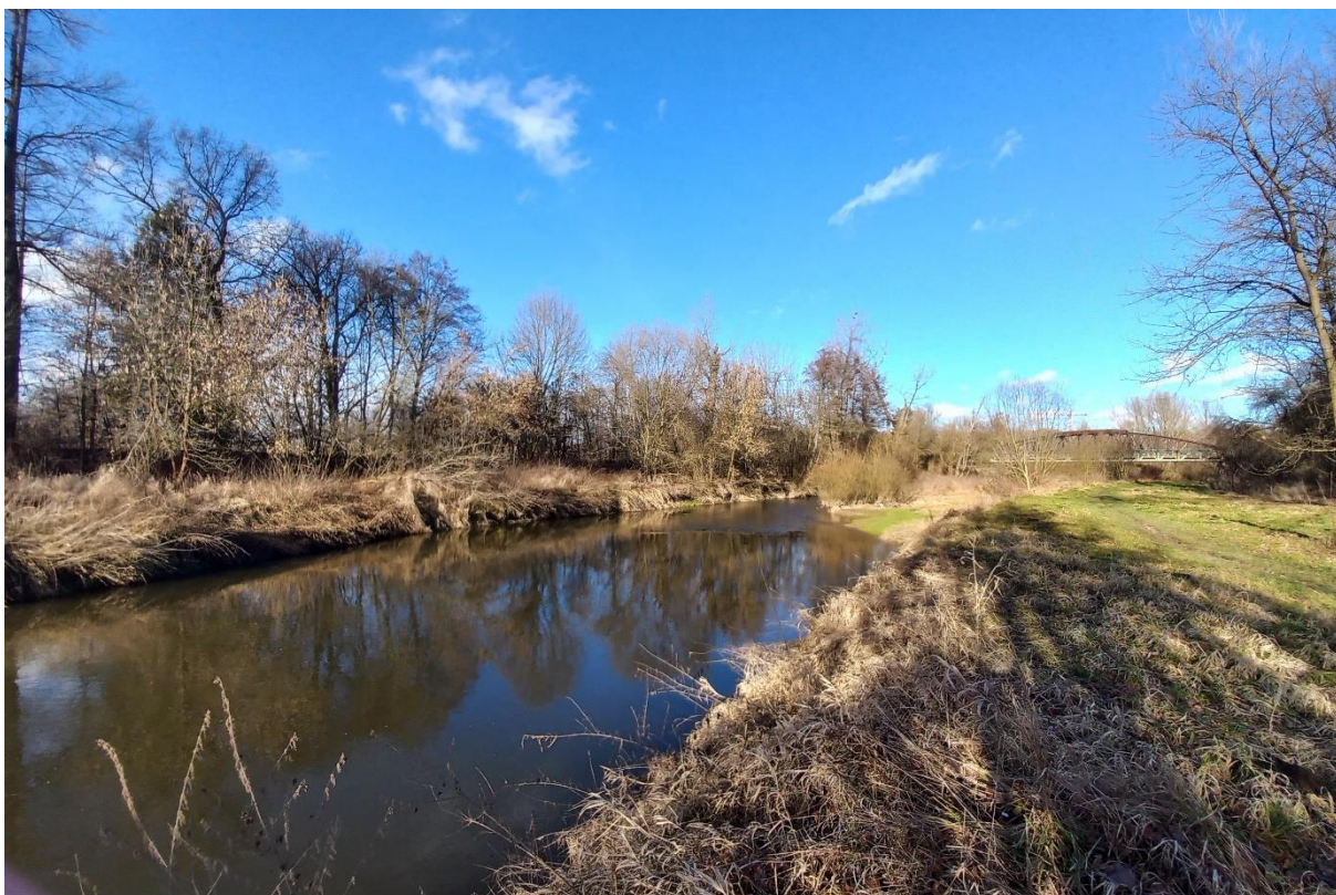
Obr. Úsek pod Červeňákem, levobřežní berma zarostlá, v pozadí patrná linie hráze, pravobřežní berma řídkce porostlá.
